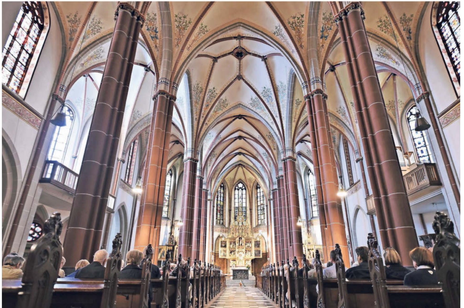
Die Katholische Kirche St. Cyriakus liegt mitten in Hüls, Feuchtigkeit macht ihr zu schaffen.
